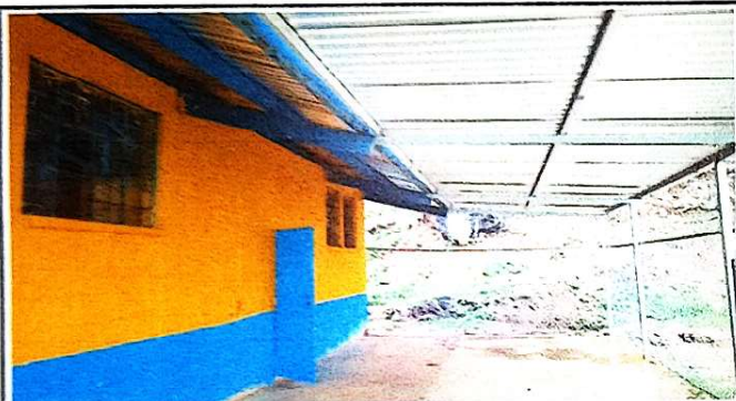
Foto 3: Corredor terminado de instalacion
